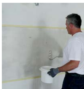
1. lépés: a fogadó felület előkészítése, leragasztása és – szükség esetén – alapozása
