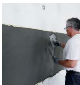
3. lépés: egy nap várakozási idő után: a második réteg finomhabarcs felhordása és elsímítása
