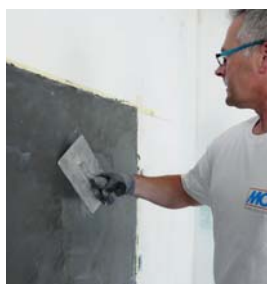
4. lépés: finombeton hatású impregnálás MC-Color Proof pure-ral
