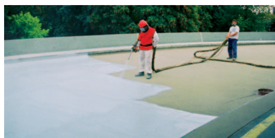
3. MC-Flex 2298 szigetelő réteg felvitele kétkomponenses szórásos eljárással.
