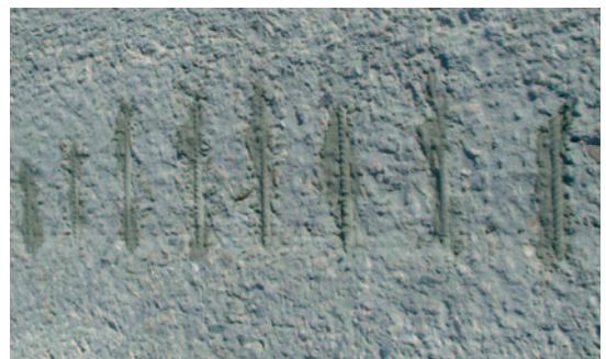
1. Szabadon lévő vasalat korrózióvédelme: Zentrifix KMH.
