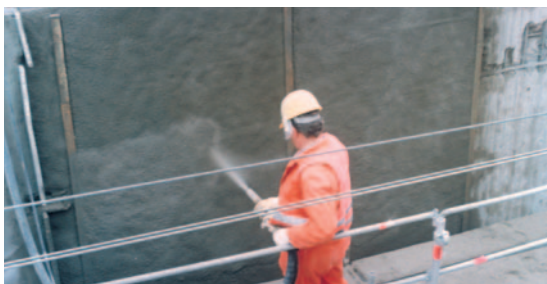
2. A betontakarás növelése.
