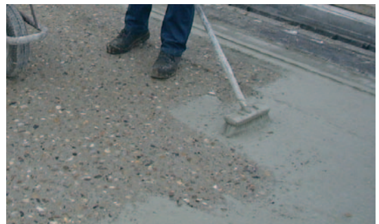
2. Tapadóhíd felvitele: Zentrifix KMH.
