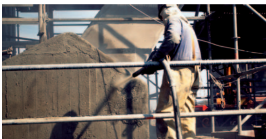
1. Betonpótlás részfelületeken.
