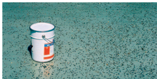
4. Kötőréteg felvitele MC-DUR 2295 LM-mel, zúzalék behintéssel.
