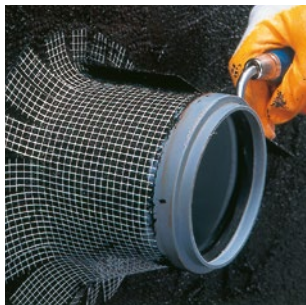
Lekenés a második bitumenréteggel
