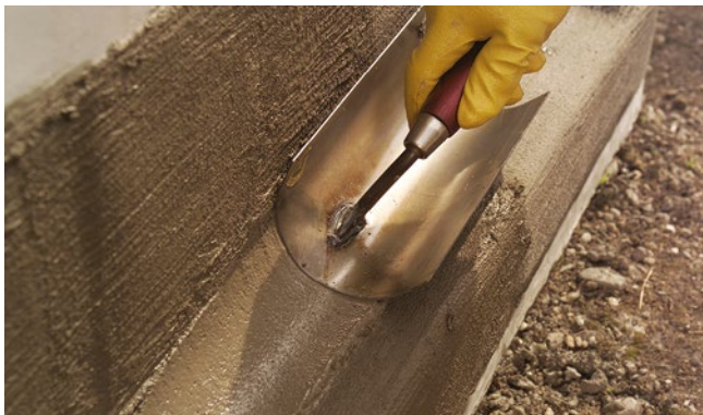
Ásványi hornyolt falcsatlakozás kialakítása hajlított simítóval
