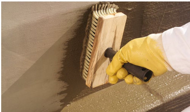
Szigetelőiszap felhordása a sávalap környékén
