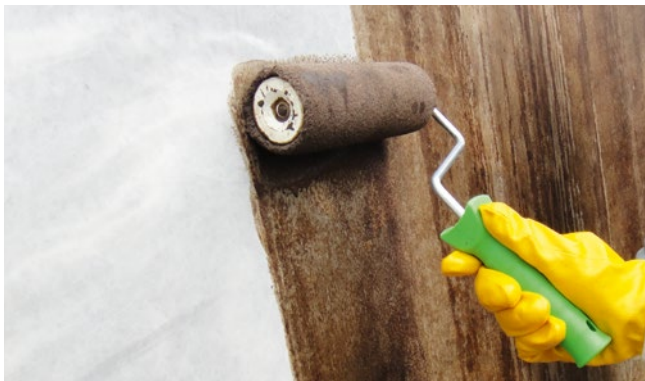
Az alapozó felhordása hengerrel
