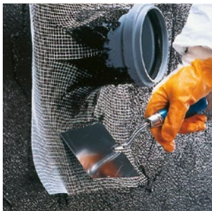
Beágyazás az első bitumenrétegbe
