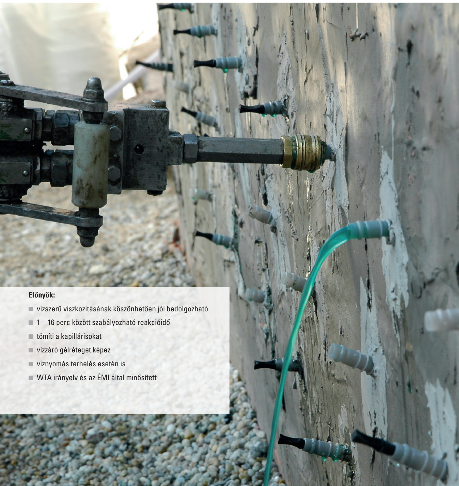
Vízserű viszkozitásnak köszönhetően az Oxal Dry-In mindenhova behatol, ahova a talajvíz is
