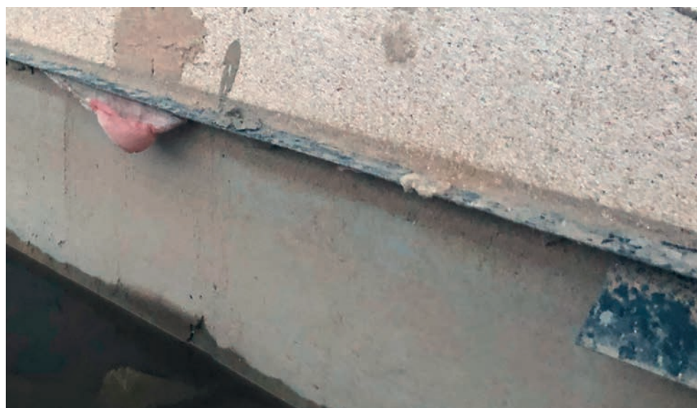
Keresztmetszeti szigetelés hagyományos lemezes megoldással
