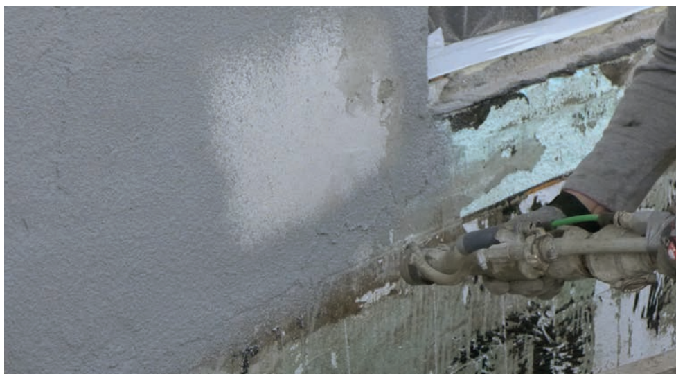
Anyag felhordása meglévő bevonatra gépi szórásos technikával
